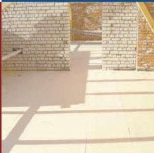
При утеплении полов по перекрытию, например, над холодным подвалом предварительная установка гидроизоляции не требуется. Плиты URSA XPS укладываются по бетонному основанию так, чтобы стыки плит теплоизоляции не попадали на стыки плит перекрытия. Такая укладка и наличие ступенчатой кромки обеспечивает сплошность слоя теплоизоляции. Применение плит URSA XPS при утеплении полов в минимальной степени уменьшает высоту помещения.
